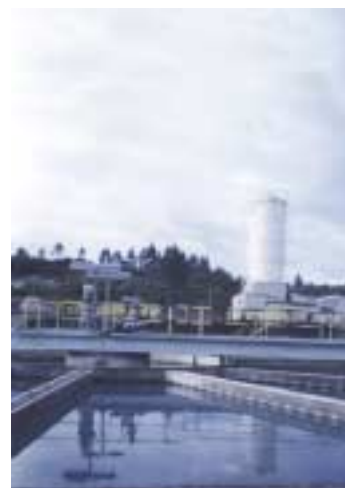
Planta de tratamientos pasivos de aguas ácidas
