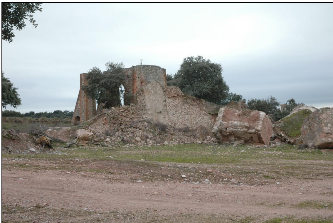
Figura 3: Zona de escombrera principal desmantelada junto al Pozo Maestro o "San Rafael" (febrero de 2009)
